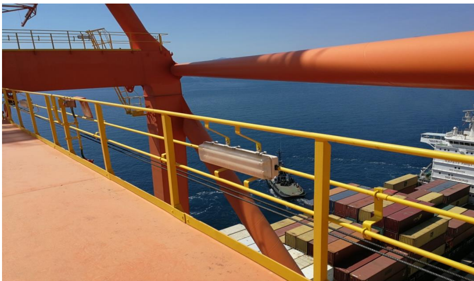
Slika 21. Ograda obalne dizalice
