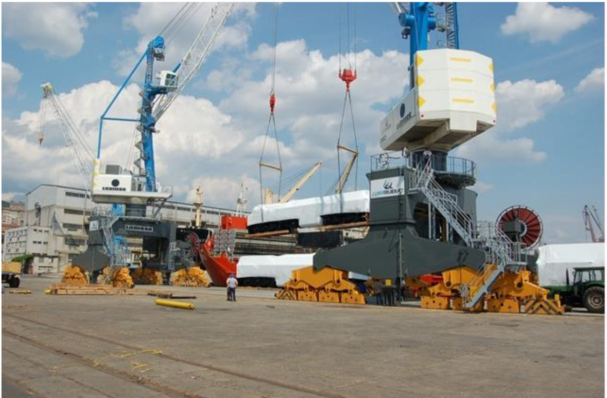
Slika 3: Terminal za konvencionalne (generalne) terete
