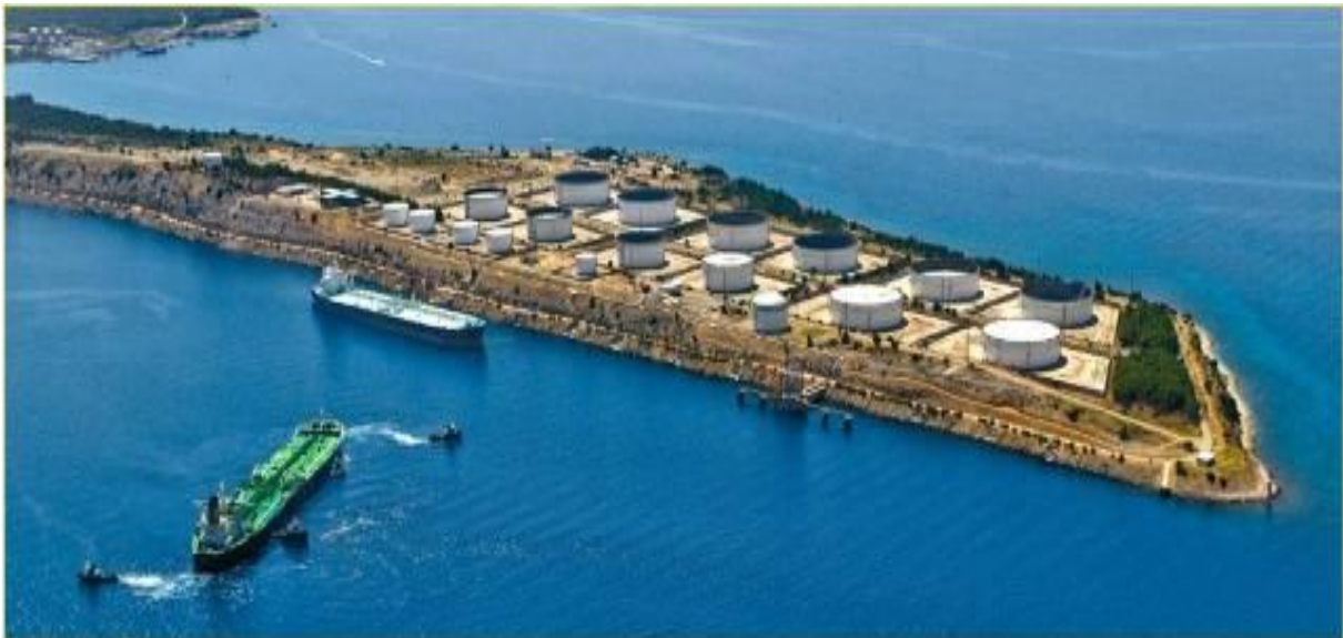
Slika 9: Terminal za naftu i naftne derivate
