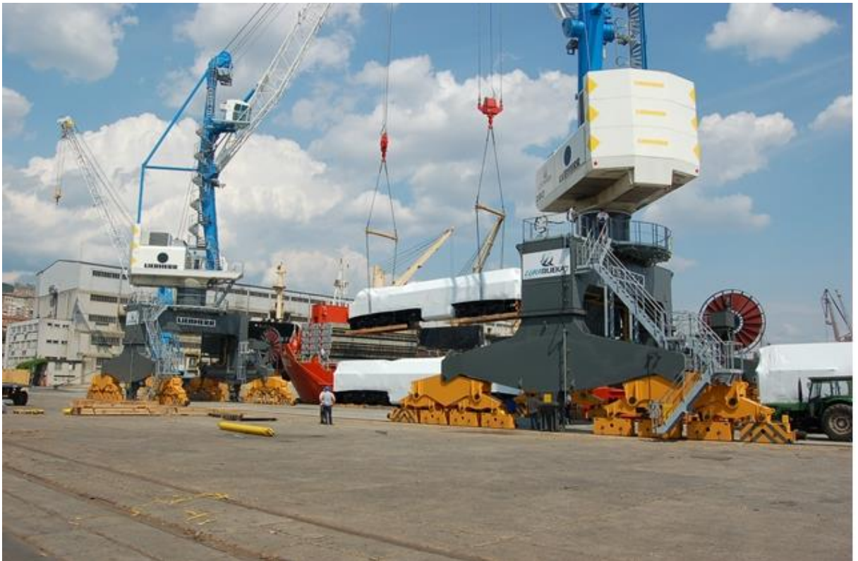
Slika 3: Terminal za konvencionalne (generalne) terete
