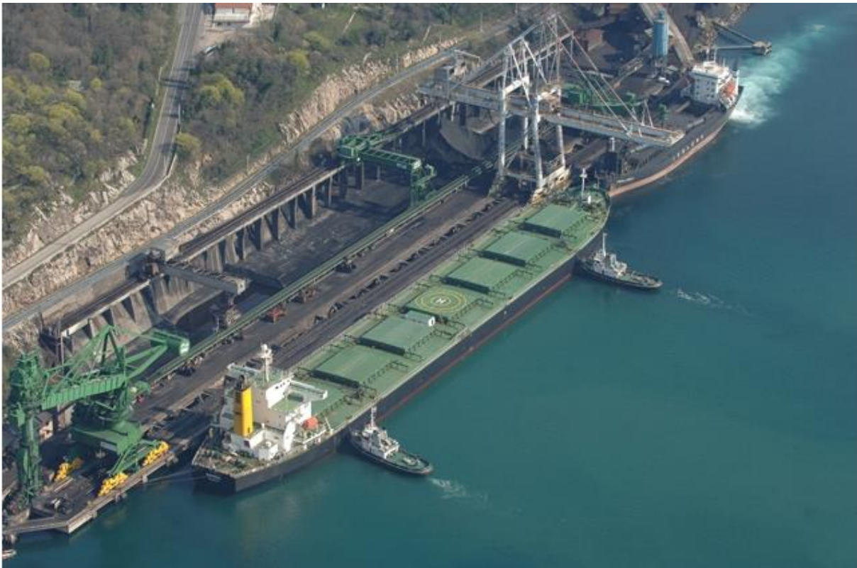
Slika 1: Terminal za rasute terete
