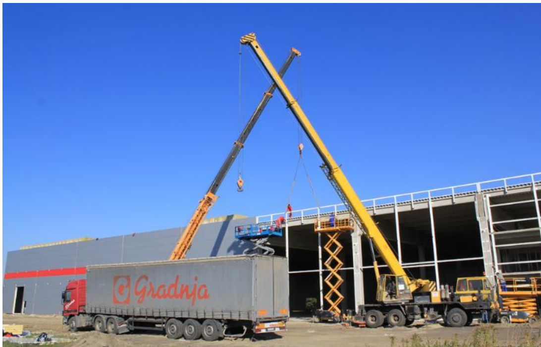
Slika 9: Izgradnja tvrtke Ricardo d.o.o
