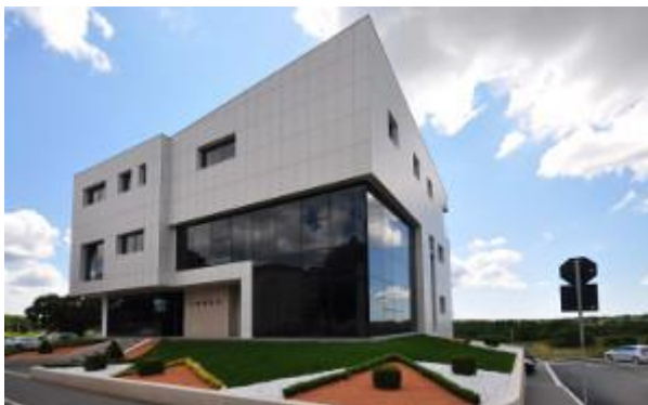
Slika 1.: Zgrada sjedišta RUDAN d.o.o. u Žminju
