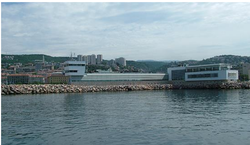
Slika 11.:Putnički terminal Rijeka sa morske strane
