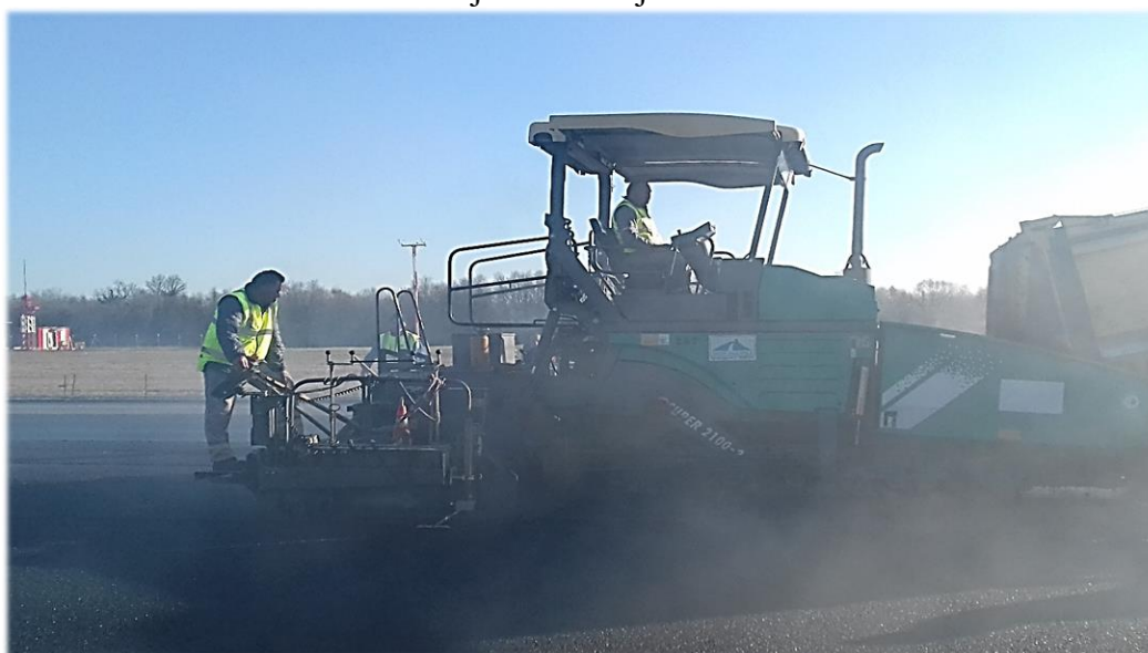
Slika 12. Stroj za rastiranje asfalta – finišer
