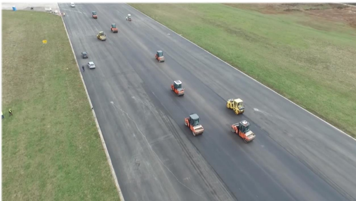
Slika 10. Zbijanje asfalta vibracijskim valjcima HAMM
