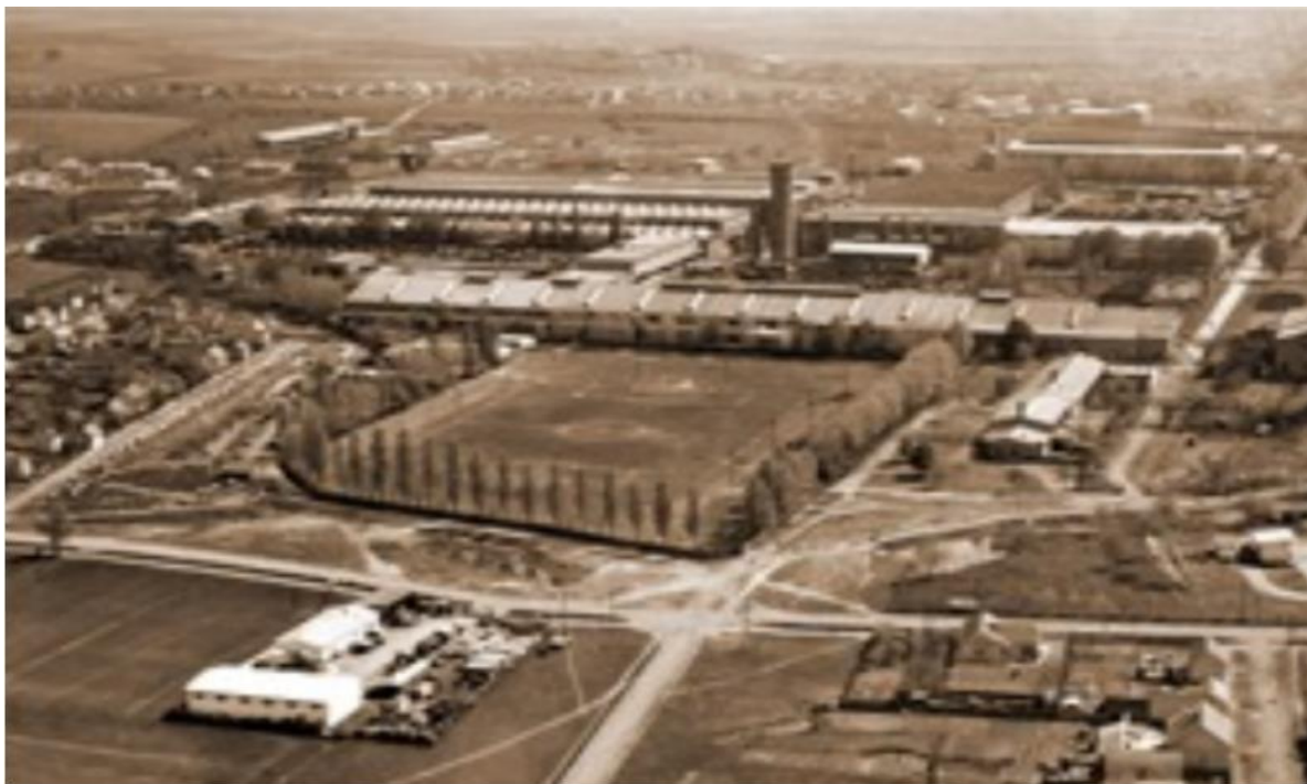
Slika 6: Postrojenje Đuro Đaković
