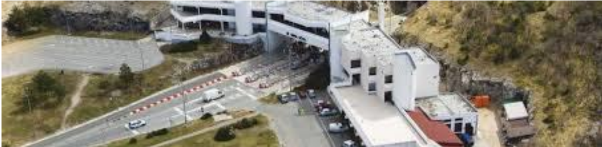
Slika10. BINA-Istra Upravljanje i održavanje d.o.o. - sjedište
