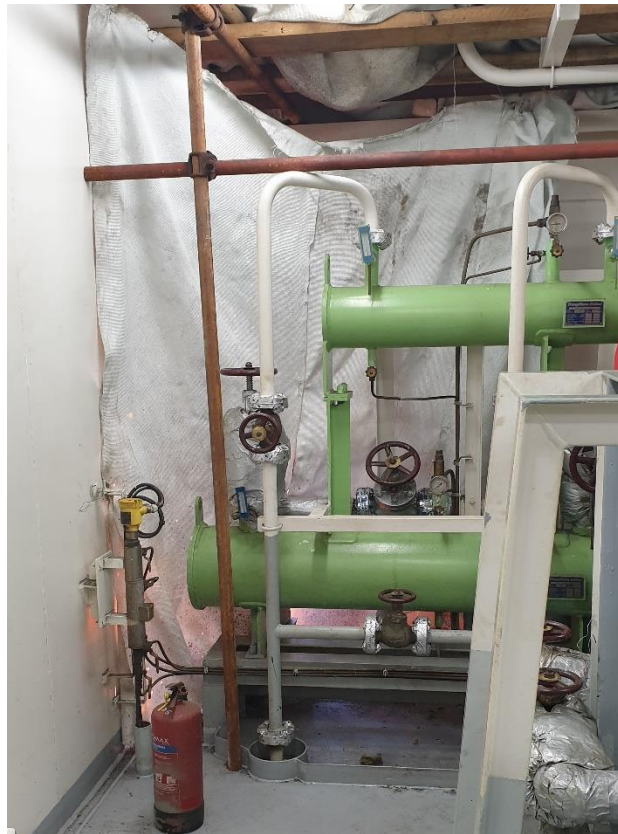
Slika 22. Zaštita pomoću negorivog platna
