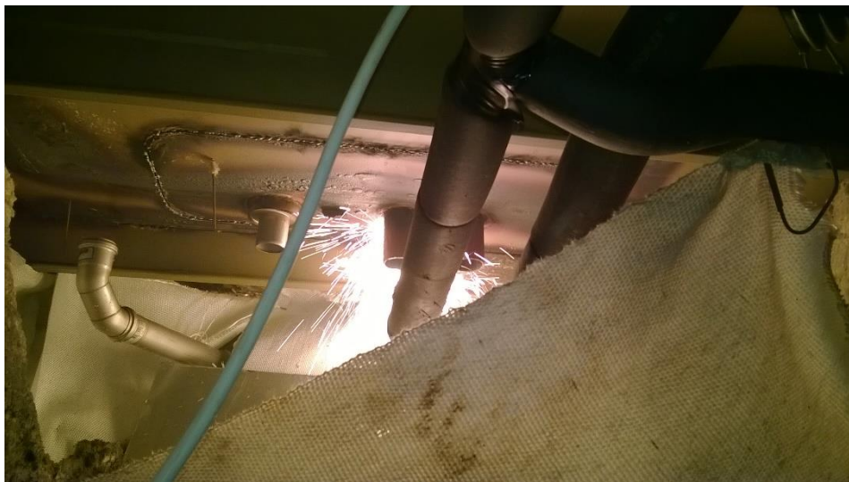
Slika 23. Zaštićivanje negorivim platnom i limom pri rezanju cijevnih prolaza
