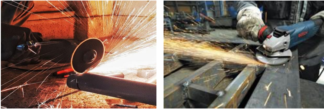
Slika 7. Iskre pri rezanju (lijevo) i brušenju (desno) metala brusilicom
