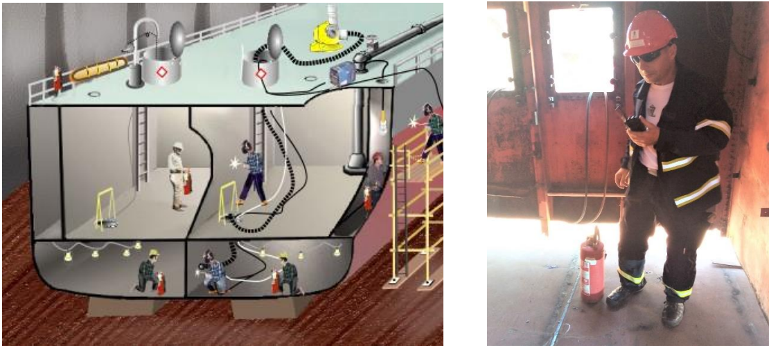
Slika 26. Osiguravanje susjednih prostora tijekom toplih radova
