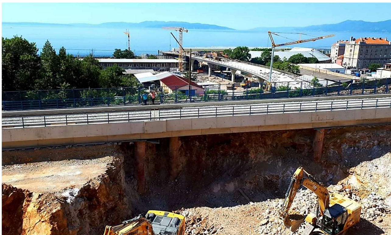
Slika 27 - Radovi izgradnja D-403
