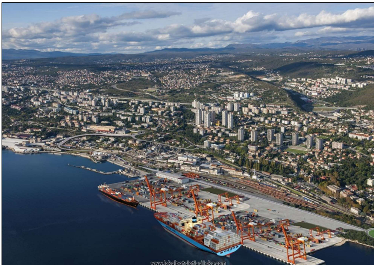
Slika 25 - D-403 i budući Zagrebački kontejnerski terminal Luke Rijeka
