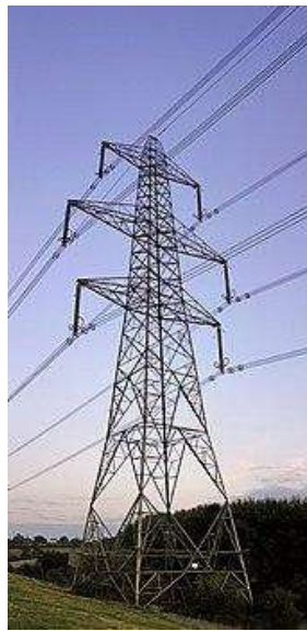
Slika 1. Čelični rešetkasti stup
