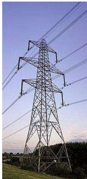
Slika 1. Čelični rešetkasti stup
