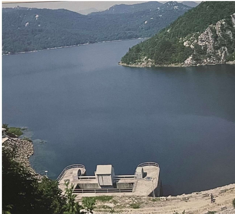
Slika 11. Preljevna građevina na brani Sklope
