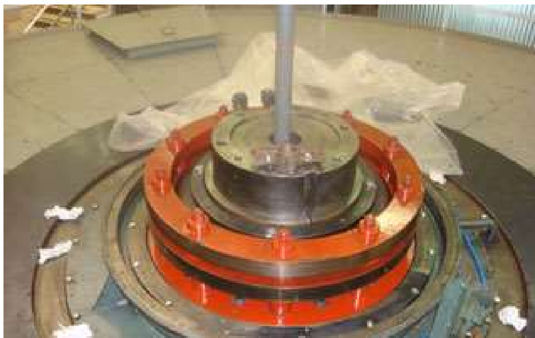
Slika 17. Radovi na generatoru (HE Senj)
