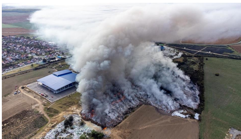
Slika 10. Požar odlagališta – prikaz iz zraka
