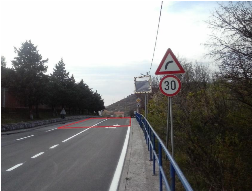
Slika 32. Označeni dio kolnika potrebnog za rekonstrukciju
