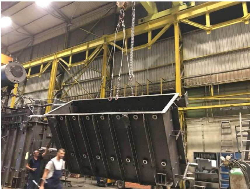
Slika 20. Podizanje predmeta obrade mosnom dizalicom
