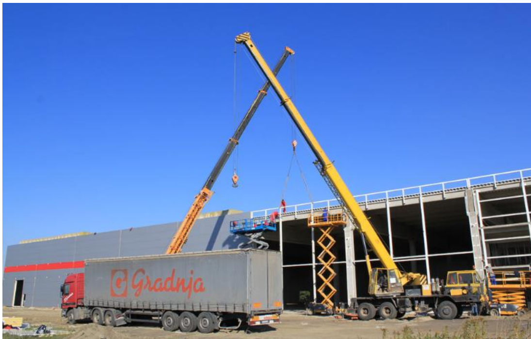
Slika 9: Izgradnja tvrtke Ricardo d.o.o
