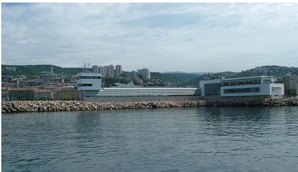
Slika 11.:Putnički terminal Rijeka sa morske strane
