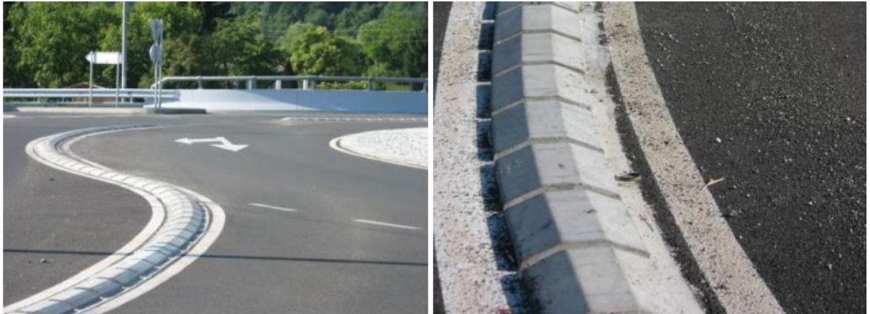
Slika 24. Fizička odvojenost kružnog prometnog traka na turbo kružnom raskrižju
