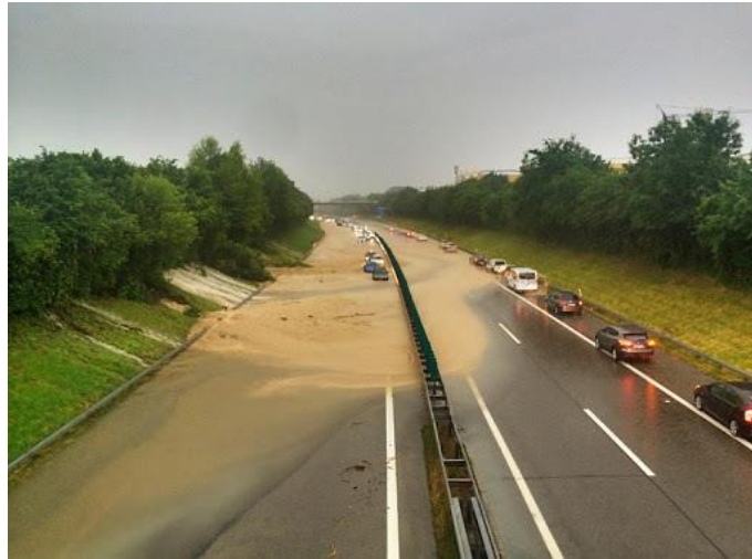
Slika17. Poplavljena dionica autoceste
