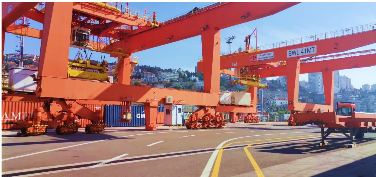
Slika 16. RMG dizalica AGCT-a
