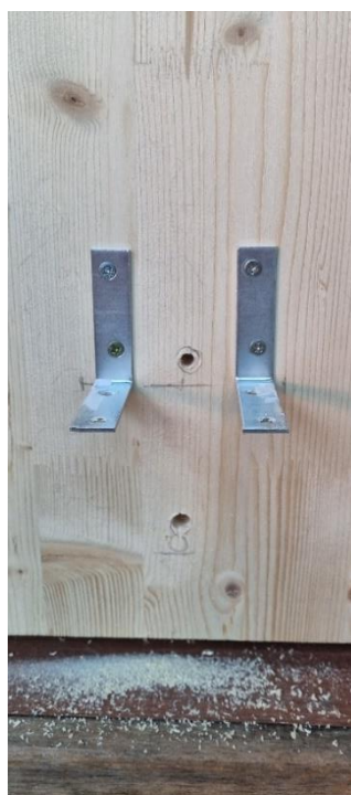
Slika 25. Bušenje rupa za pojilicu na stražnjoj stranici
