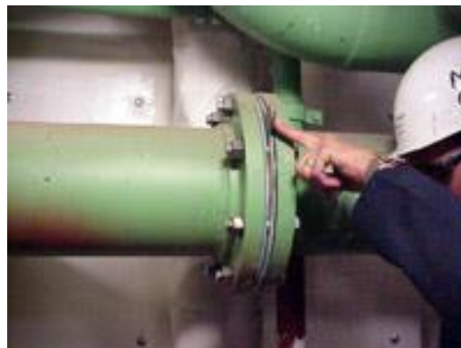
Slika 25. Blindiranje cjevovoda
