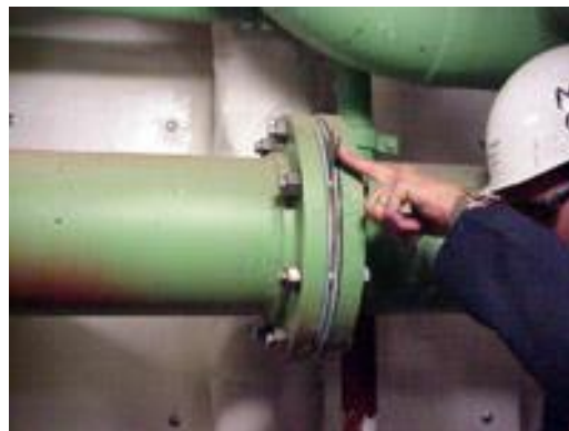
Slika 25. Blindiranje cjevovoda
