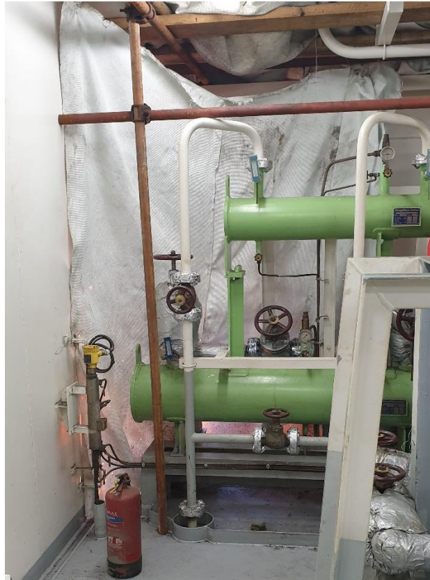
Slika 22. Zaštita pomoću negorivog platna
