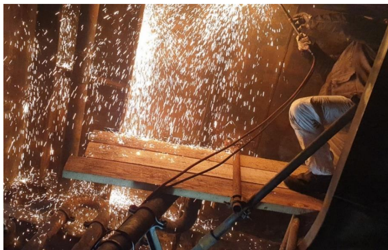
Slika 5. Prskanje taline pri rezanju čelika plinskim rezačem
