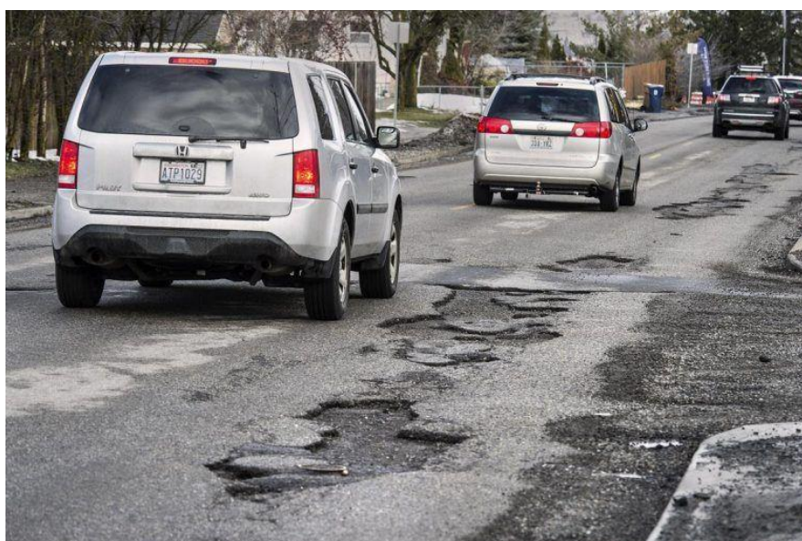
Slika 3. Prikaz udarnih rupa na prometnicama
