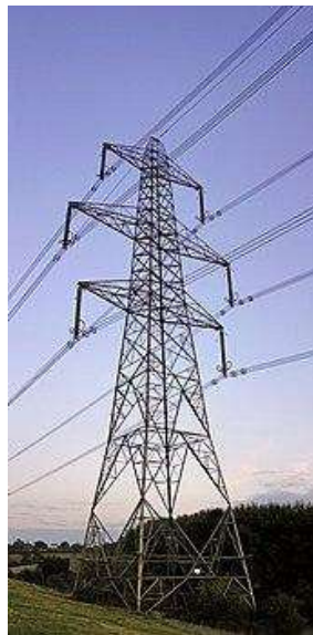
Slika 1. Čelični rešetkasti stup
