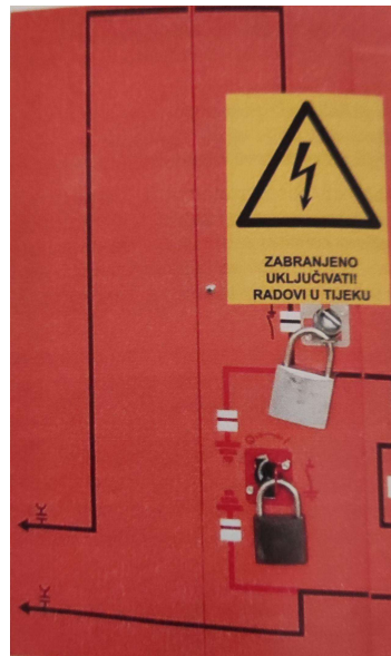
Slika 7. Blokiranje ponovnog uključanja
