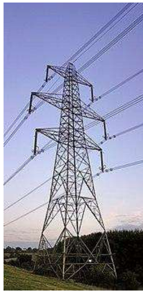
Slika 1. Čelični rešetkasti stup
