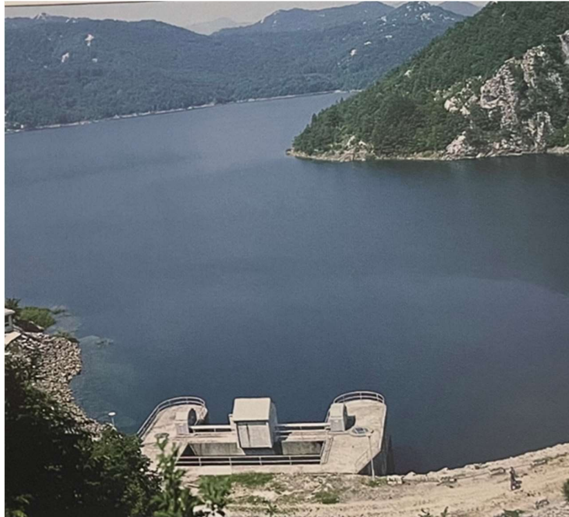
Slika 11. Preljevna građevina na brani Sklope
