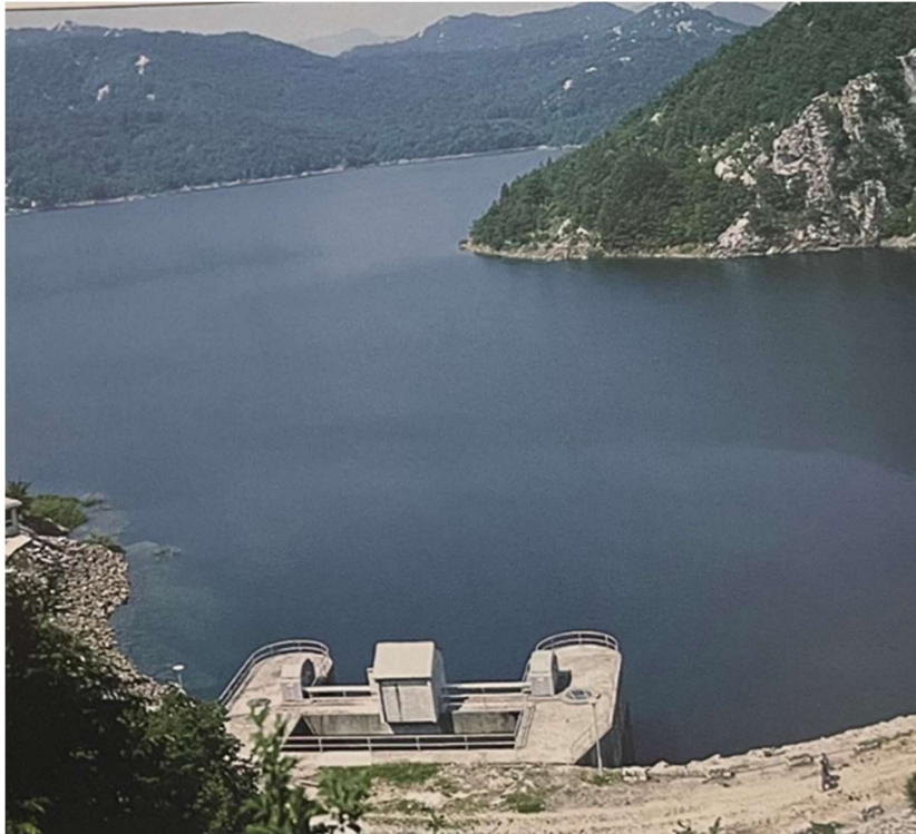
Slika 11. Preljevna građevina na brani Sklope
