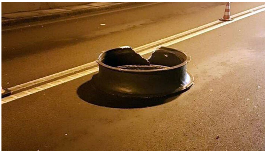
Slika 10. Incidentna situacija- prepreka na kolniku u tunelu Učka
