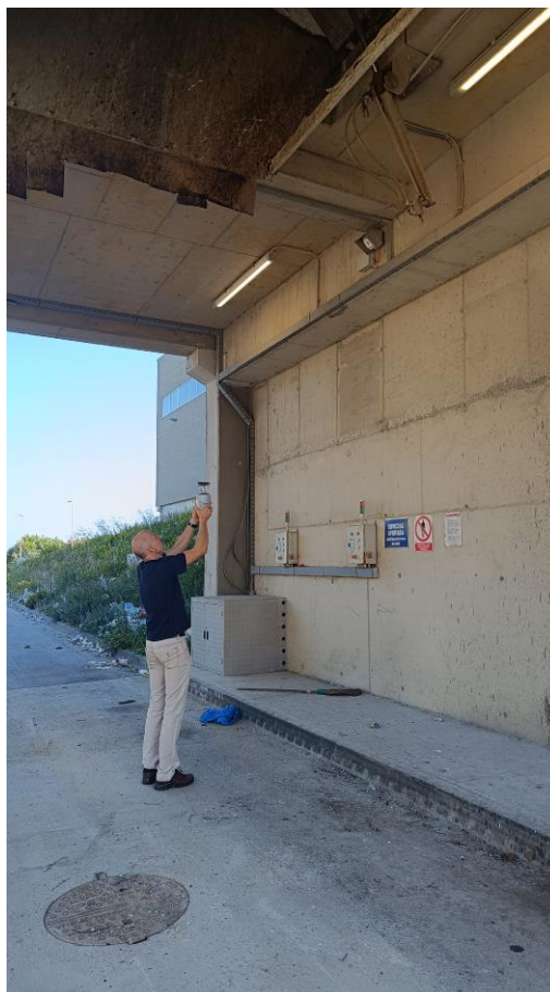
Slika 17. Ispitivanje sustava vatrodojave na Reciklažnom dvorištu „Treskavac“, otok Krk
