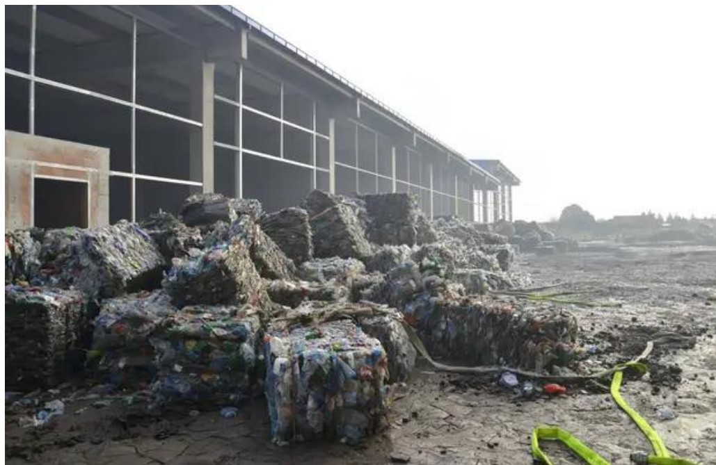
Slika 13. Stanje odlagališta nakon požara
