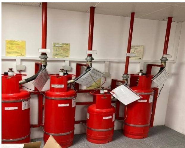
Slika 7. Spremnici sustava FM-200
