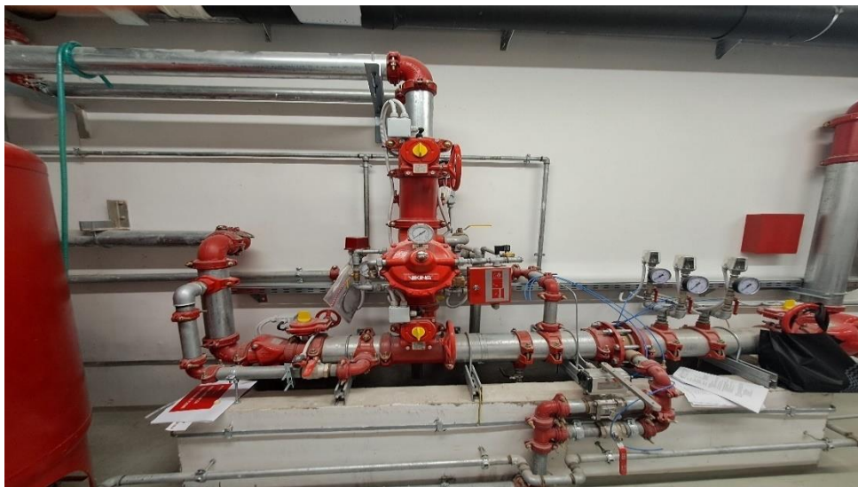
Slika 2. Stanica sustava s pjenom
