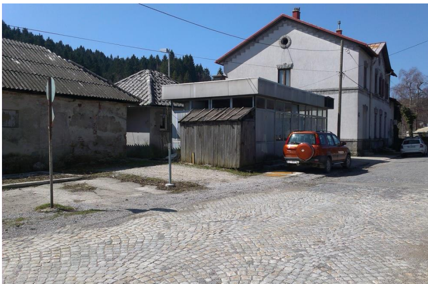
Slika 18. Izgradnja parkinga u neposrednoj blizini kolodvora
