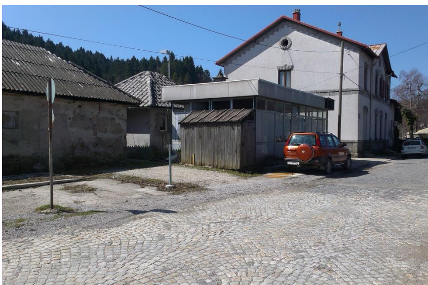
Slika 18. Izgradnja parkinga u neposrednoj blizini kolodvora
