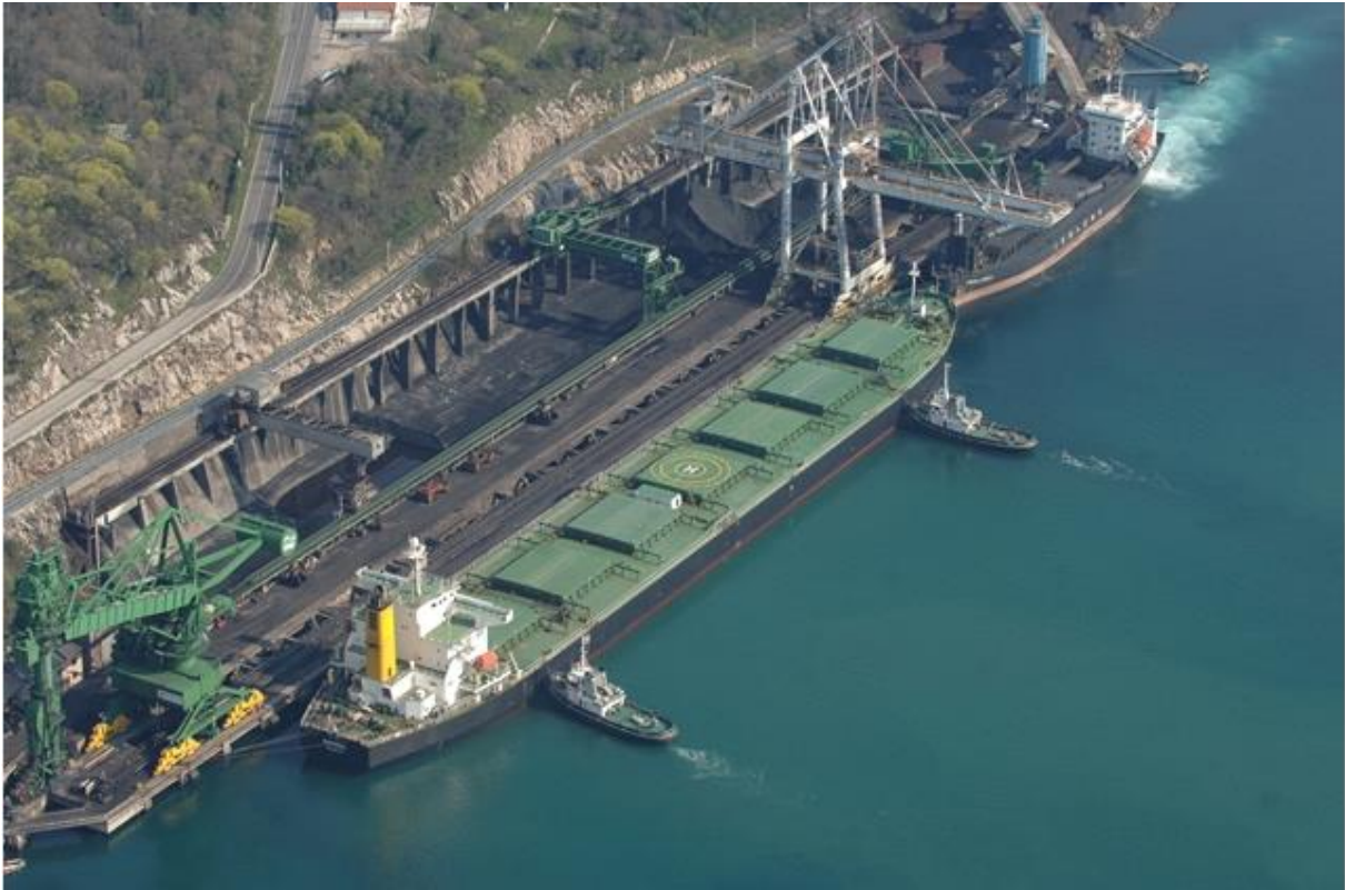
Slika 1: Terminal za rasute terete
