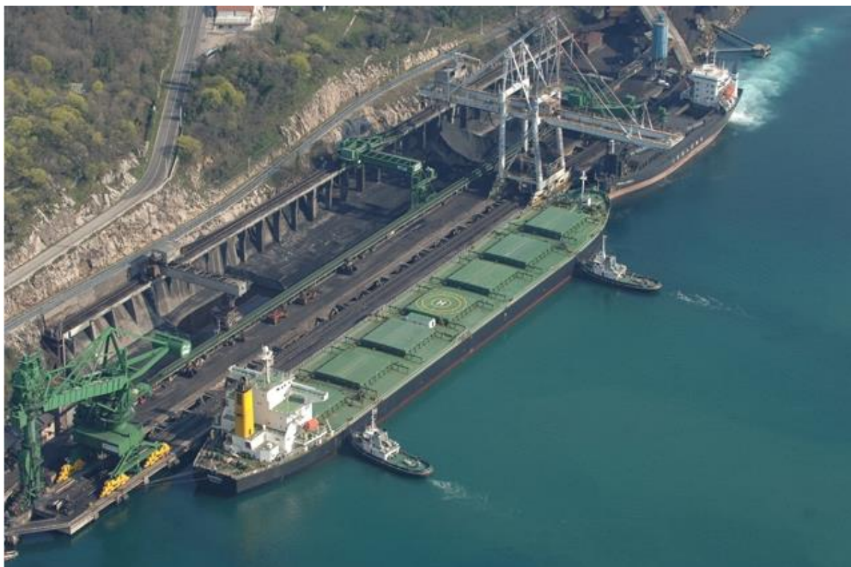
Slika 1: Terminal za rasute terete
