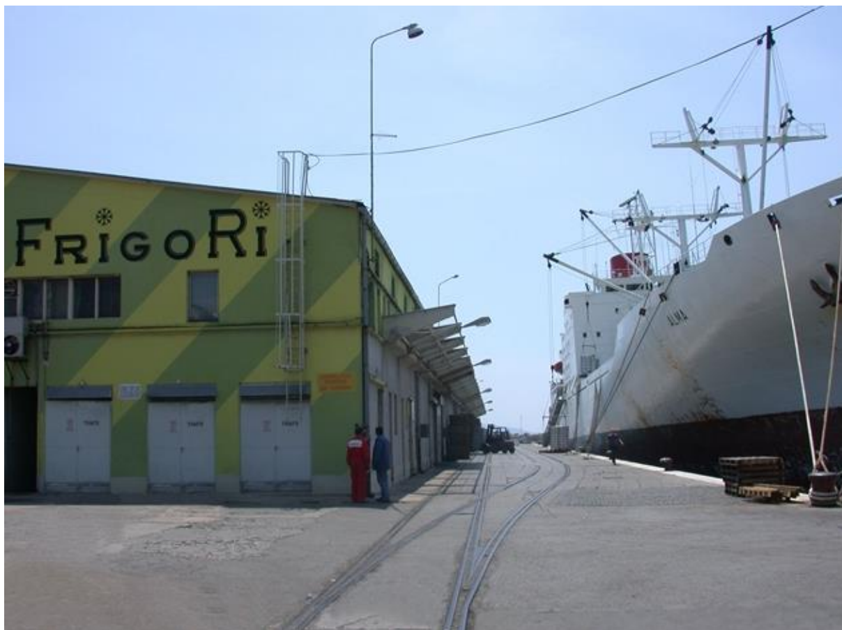
Slika 7: Terminal za kondicionirane terete
