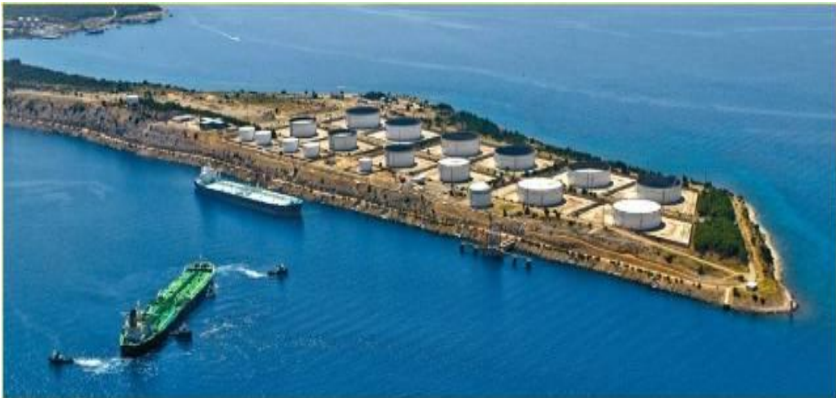
Slika 9: Terminal za naftu i naftne derivate
