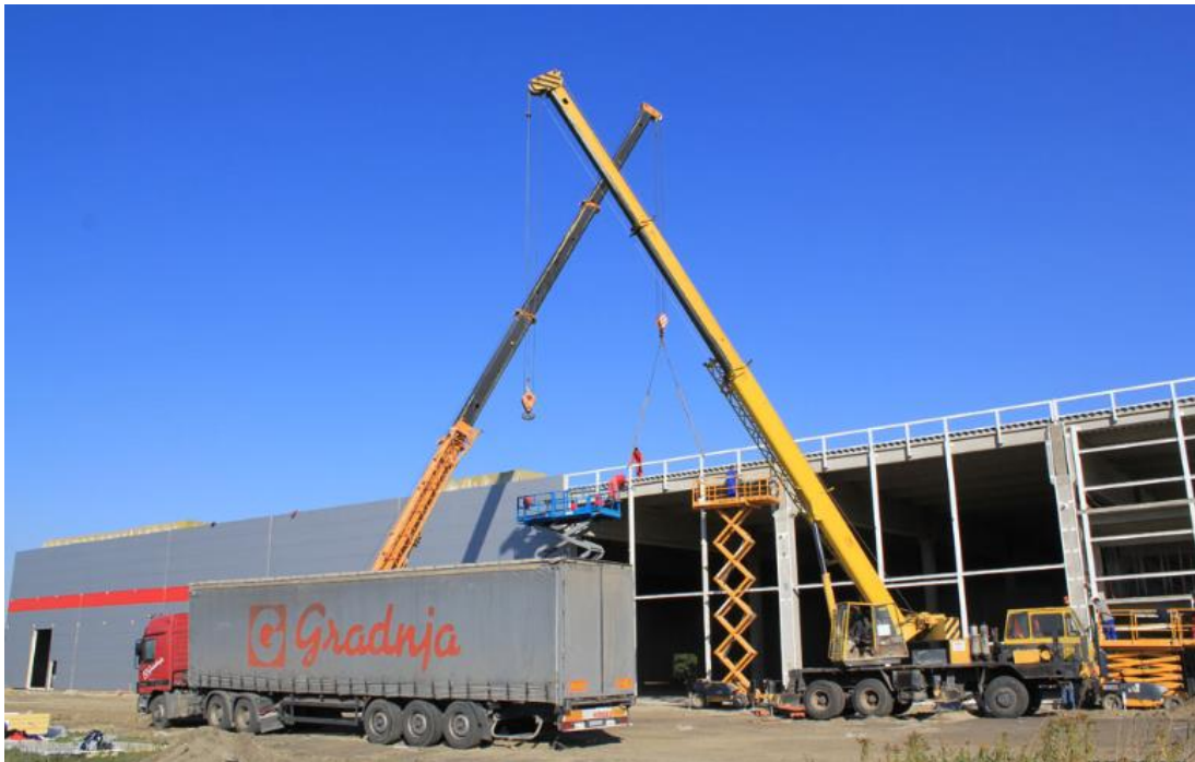
Slika 9: Izgradnja tvrtke Ricardo d.o.o
