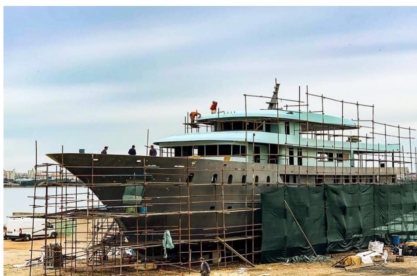
Slika 4: Brod „Sea Swallow“ u izgradnji
