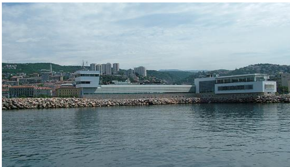
Slika 11.:Putnički terminal Rijeka sa morske strane
