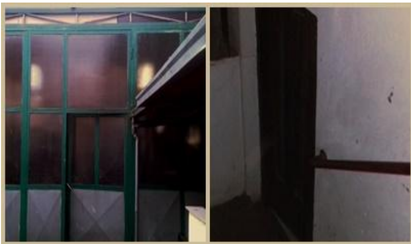
Slika 8. Glavni ulaz u proizvodni pogon i ulaz između proizvodnog pogona i skladišta
