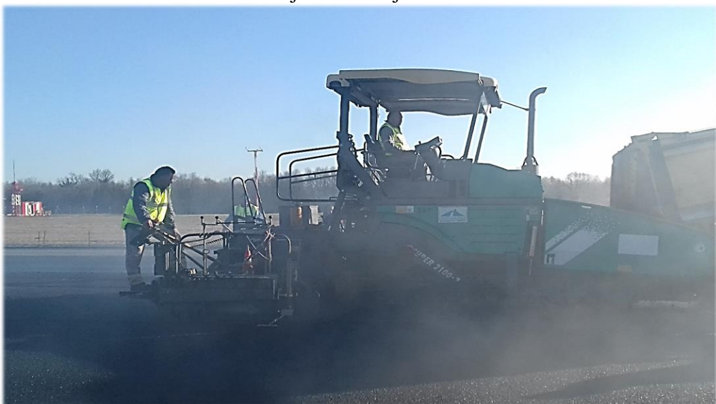
Slika 12. Stroj za rastiranje asfalta – finišer
