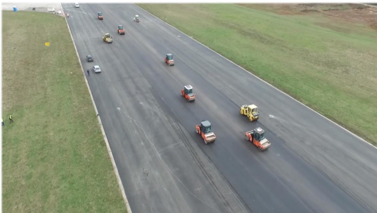
Slika 10. Zbijanje asfalta vibracijskim valjcima HAMM
