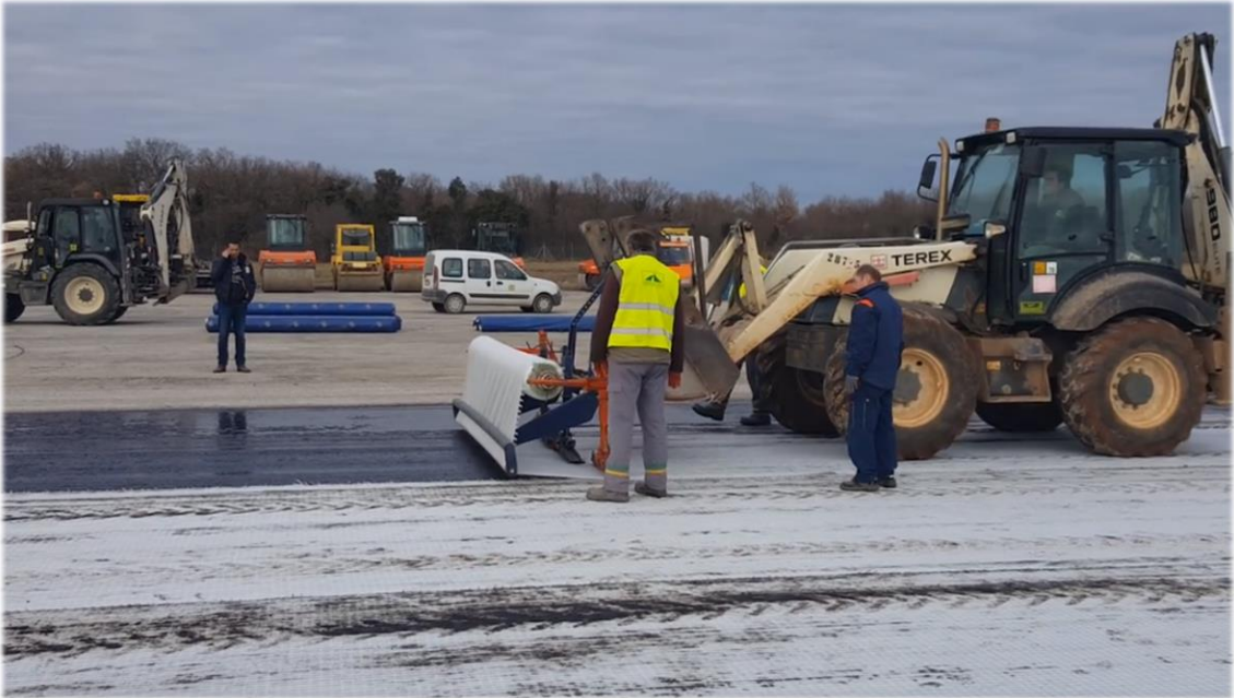
Slika 6. Postavljanje geomreže na uzletno sletnoj stazi
