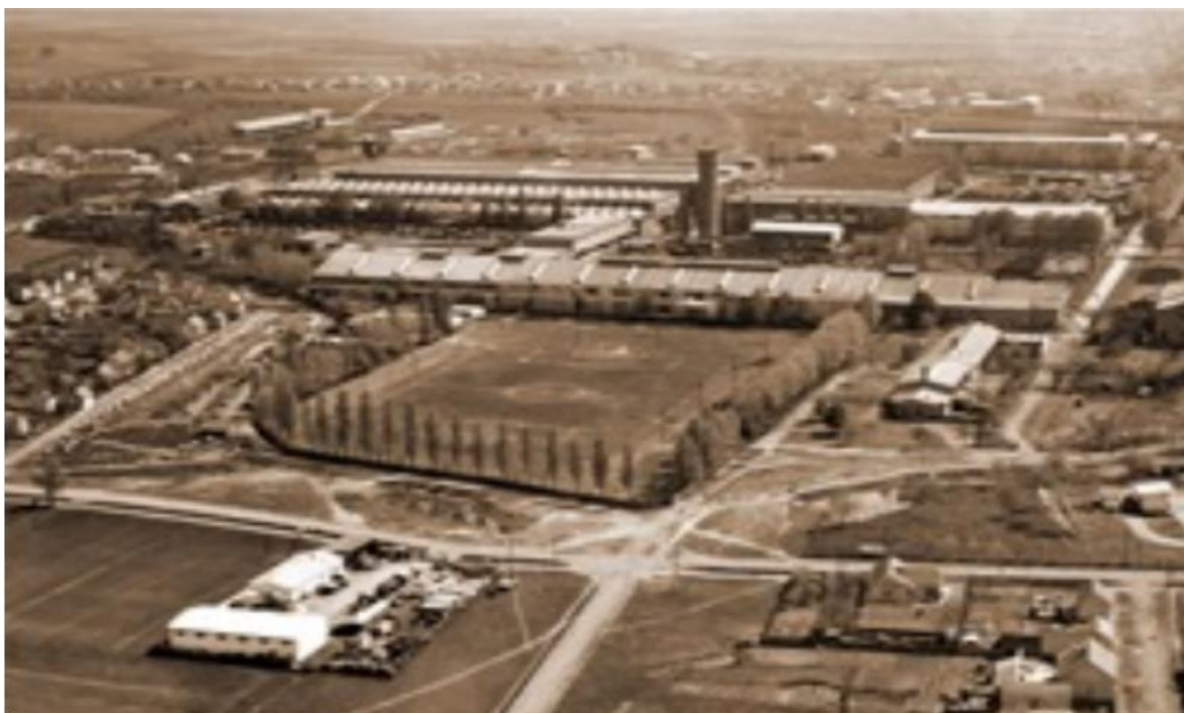
Slika 6: Postrojenje Đuro Đaković
