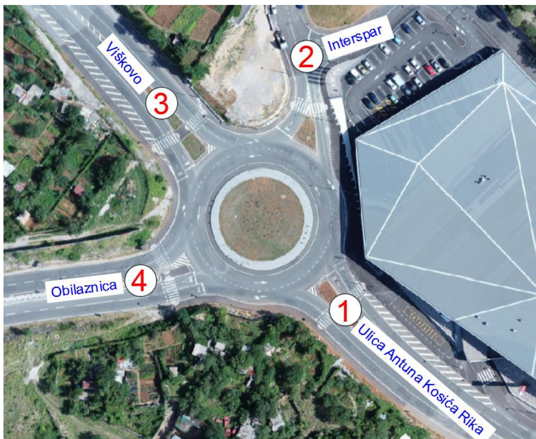
Slika 50. Orto foto postojeće stanja dvotračnog kružnog raskrižja Rujevica
