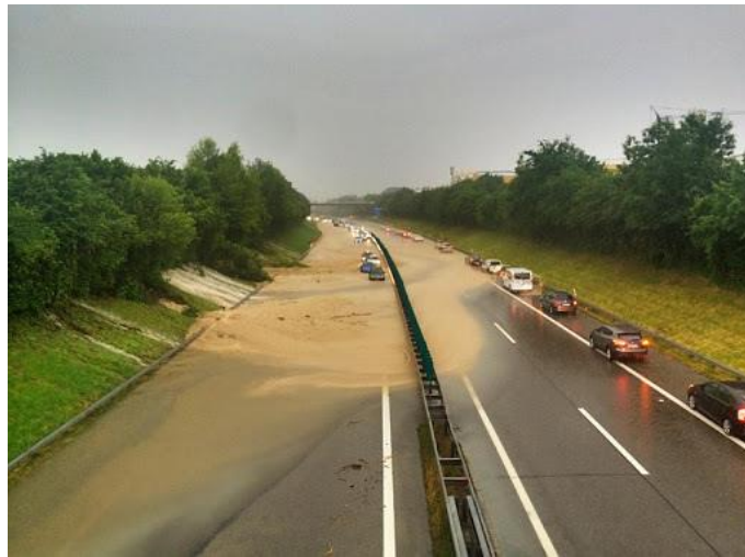
Slika17. Poplavljena dionica autoceste
