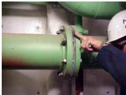
Slika 25. Blindiranje cjevovoda
