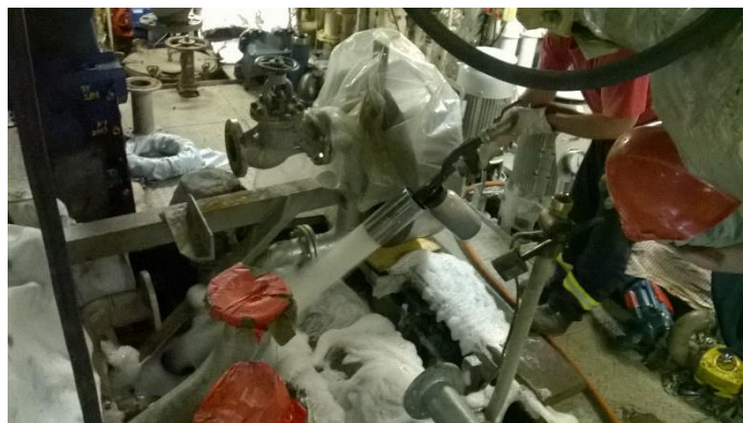
Slika 31. Prekrivanje zauljenih površina pjenom
