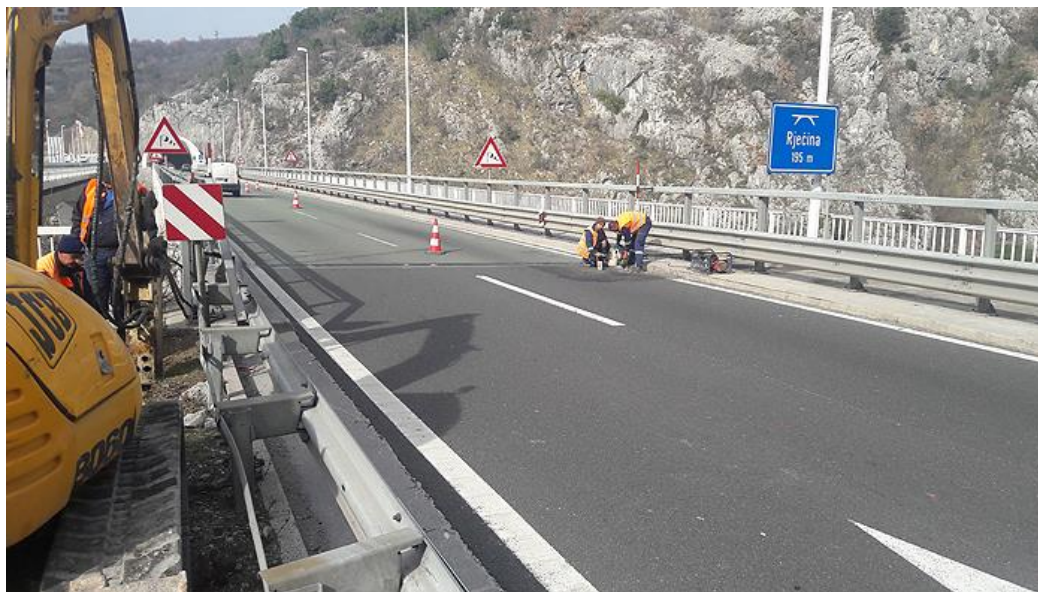
Slika 4. Prikaz sanacije autoceste A3
