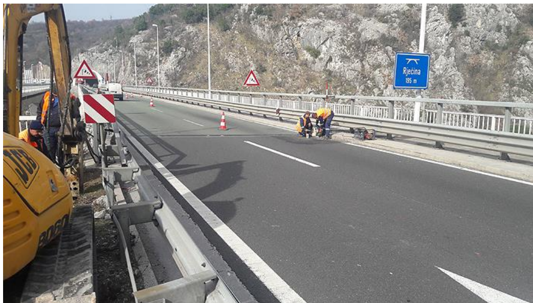
Slika 4. Prikaz sanacije autoceste A3
