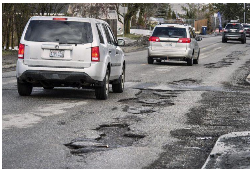
Slika 3. Prikaz udarnih rupa na prometnicama
