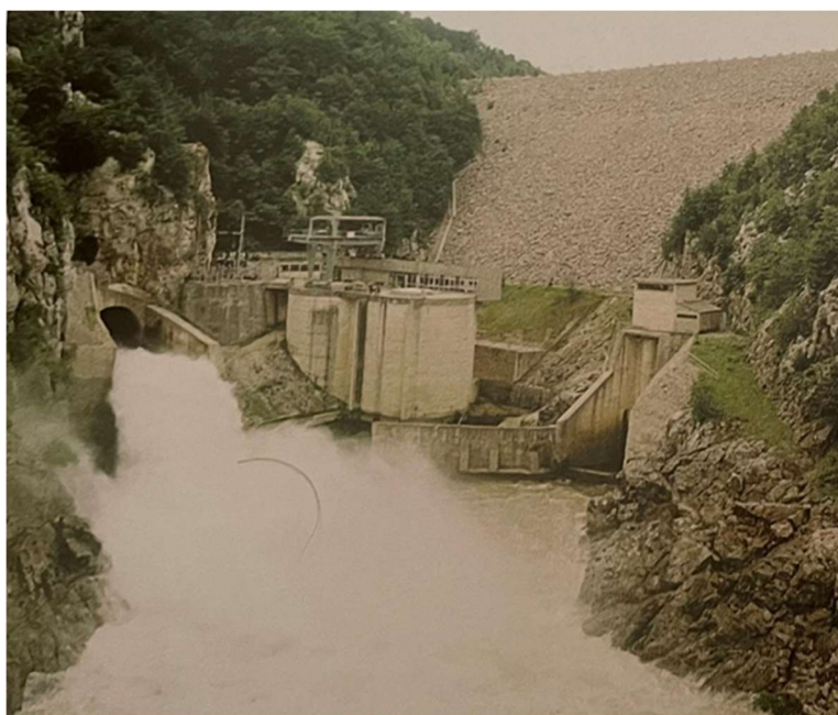
Slika 10. Pogled na branu i strojarnicu
