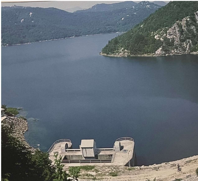
Slika 11. Preljevna građevina na brani Sklope
