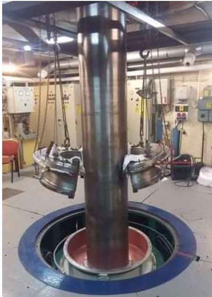
Slika 16. Radovi na turbini
