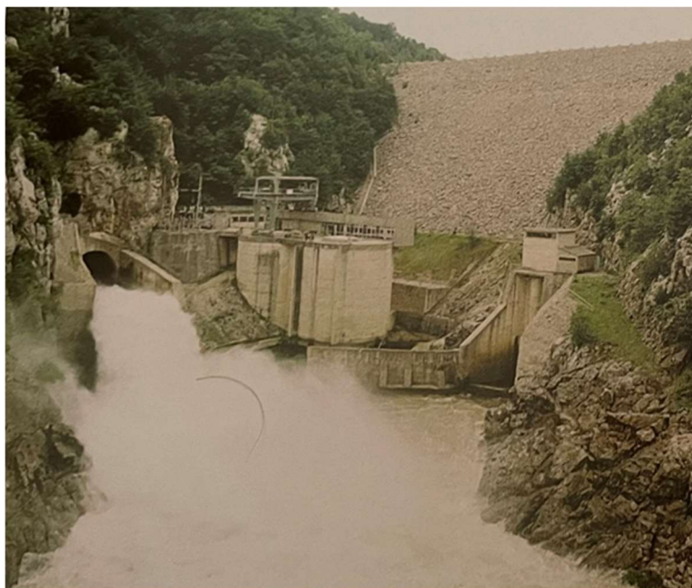
Slika 10. Pogled na branu i strojarnicu
