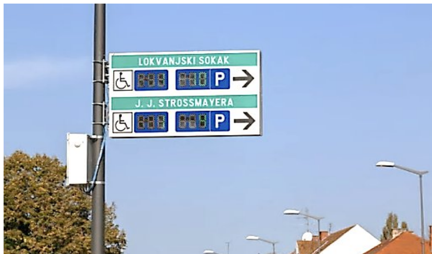
Slika 16. Dinamički znak sa numeričkim prikazom točnog broja slobodnih mjesta
