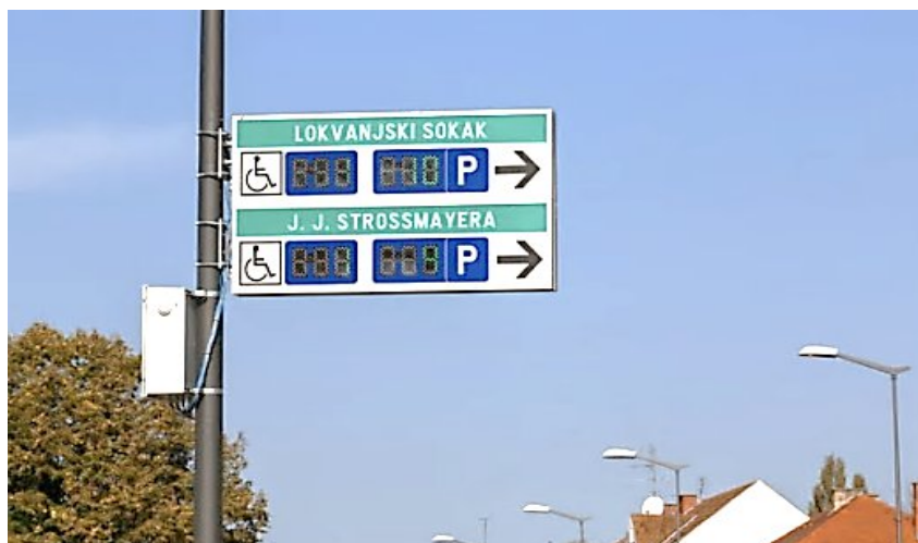
Slika 16. Dinamički znak sa numeričkim prikazom točnog broja slobodnih mjesta
