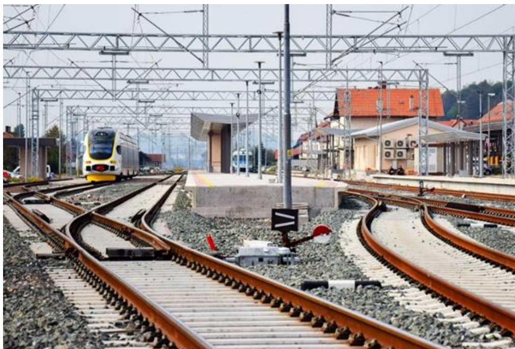
Slika 1. Željeznička infrastruktura i suprastruktura
