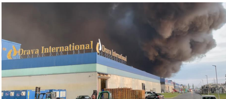
Slika 11. Zgrada tvrtke Drava International d.o.o. u trenutku požara
